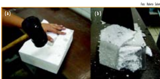
Figura 4.48 (a) y (b) - Retirada de la poliespuma
