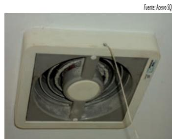
Figura 95. Extractor del cuarto oscuro necesitando de una limpieza
